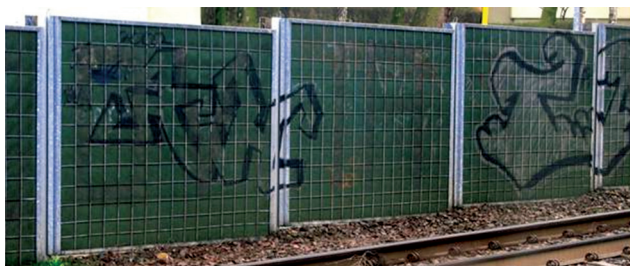
Fot. 2. Przykład problemów związanych z utrzymaniem ekranów akustycznych (wandalizm i przyspieszone w czasie zużycie)
