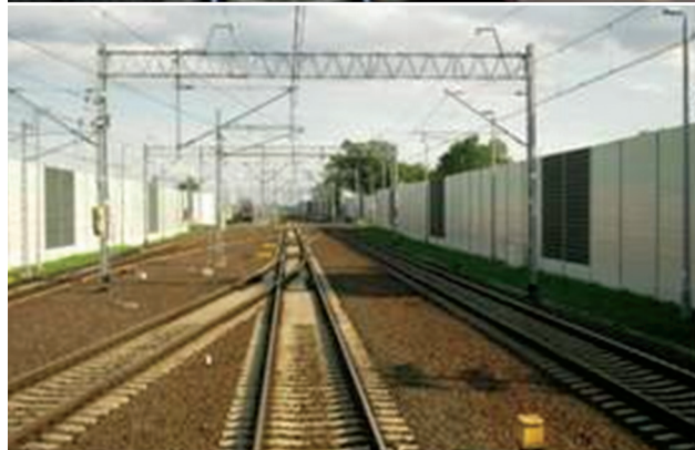
Fot. 3. Przykładowy problem braku wyjść ewakuacyjnych na większych długościach ekranów akustycznych – czy dzisiejsze z pozoru estetyczne rozwiązania nie staną się w przyszłości śmiertelnymi pułapkami?
