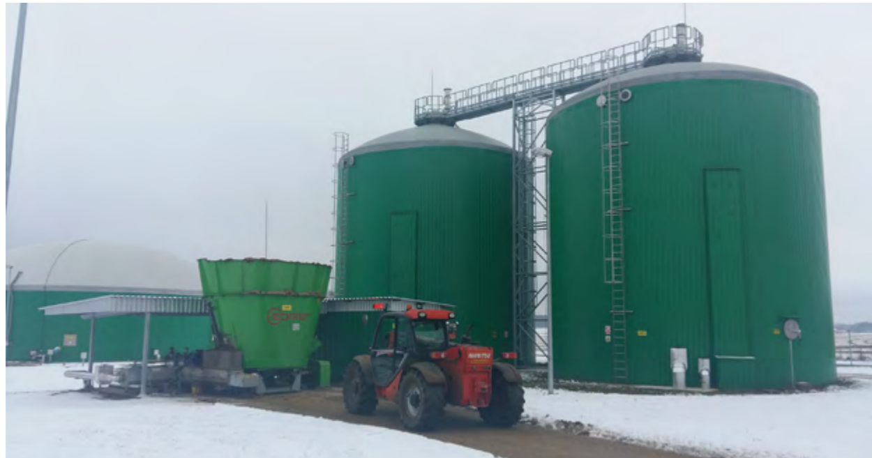
Biogazownia w Sieńsku
