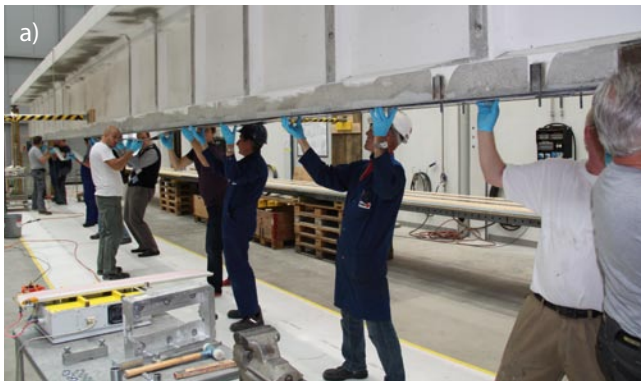
Rys. 7. Wzmocnienie dźwigara: a) na zginanie; b) na ścinanie
