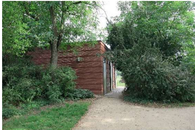
Fot. 2. Toaleta na terenie ogrodu Wörlitz, Niemcy, fot. R. Stachańczyk 2021
