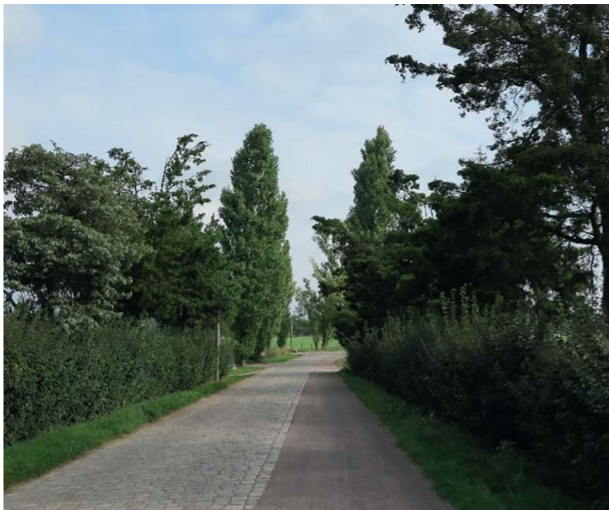
Fot. 10. Przykład poszerzenia nawierzchni brukowej o pas nawierzchni mineralnej, Wörlitz, Niemcy, fot. R. Stachańczyk 2021
