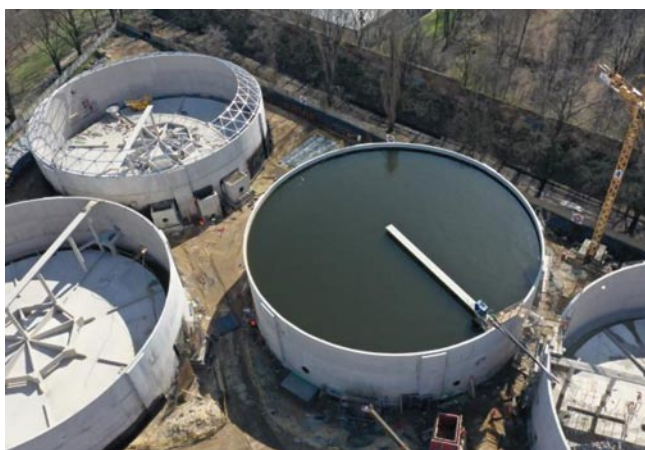
Rys. 7. Próba szczelności zbiornika
