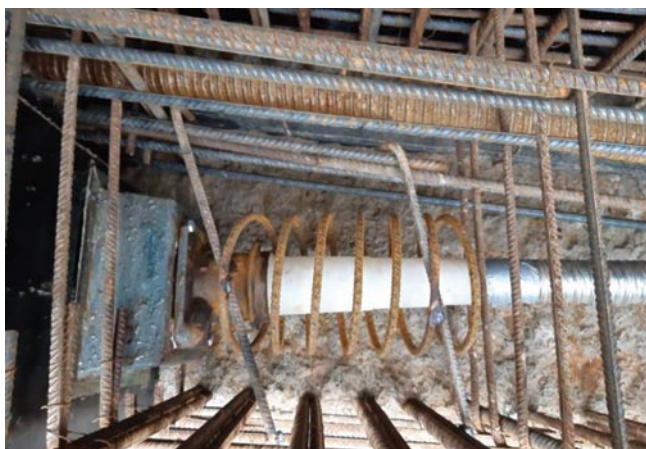
Rys. 4. Elementy podsystemu 7 MTAI 15S: żeliwny blok oporowy z przykręconym do niego stożkiem przejściowym
