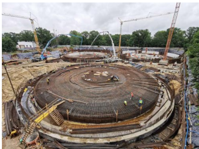
Rys. 2. Zbrojenie płyty fundamentowej
