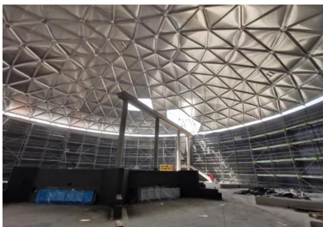
Rys. 9. Przekrycie zbiornika: gotowa konstrukcja kopuły pokryta trójkątnymi arkuszami blachy ze stopu aluminium
