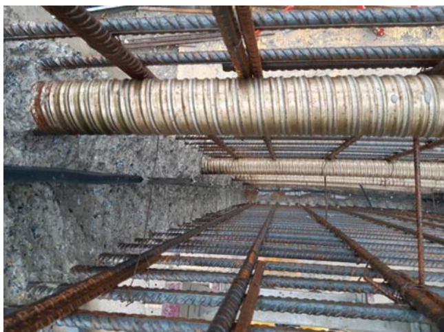
Rys. 6. Segment ściany zbiornika z widocznymi stalowymi osłonkami kablowymi oraz pionową i poziomą taśmą uszczelniającą
