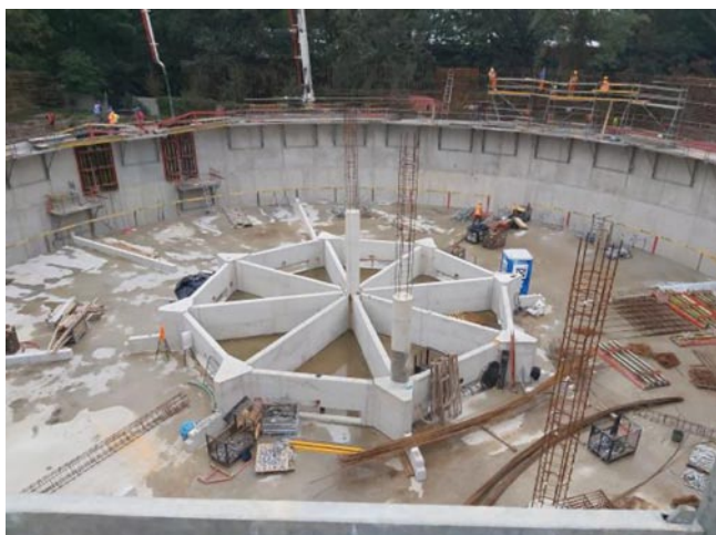
Rys. 3. Komora spiętrzająca w centralnej części zbiornika
