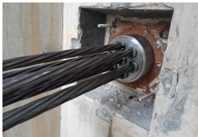
Rys. 5. Elementy podsystemu 7 MTAI 15S: blok kotwiący i szczęki trójdzielne; widoczne są także sploty siedmiodrutowe Y1860S7
