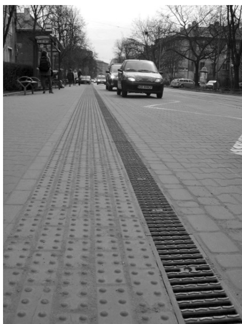
Fot. 9. Przystanek „Urzędnicza” w kierunku Bronowic – element z kostki integracyjnej i odwodnienie
