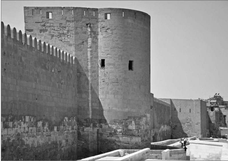
Ryc. 4. Zachowane fragmenty murów fatymidzkiego Kairu zbudowane w drugiej połowie XI w. Widok na jedną z wież wbudowaną w linię murów (fot. Tomasz Kania, 2015)
