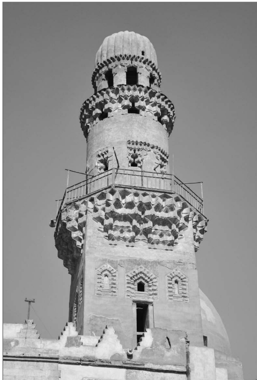
Ryc. 9. Kompleks Khanqā Baybars al-Gashankir zbudowany w latach 1306–1310. Suficki budynek mieszkalno-szkolny (fot. Tomasz Kania, 2014)
