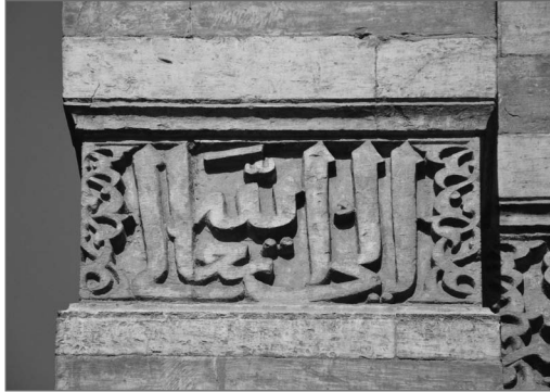
Ryc. 8. Detal architektoniczny. Kompleks Khanqā Baybars al-Gashankir zbudowany w latach 1306–1310. Suficki budynek mieszkalno-szkolny (fot. Tomasz Kania, 2014)
