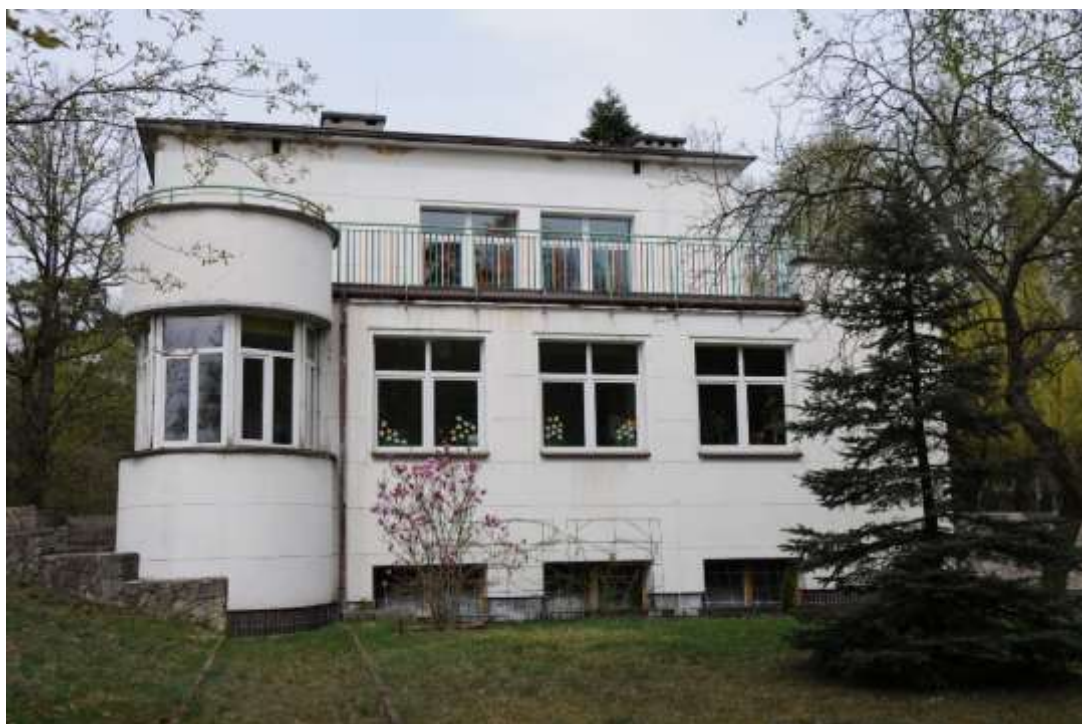
Il. 5. Willa dyrektorska w Nowej Dębie, ul. Mikołaja Reja 1, elewacja frontowa, fot. autor Ill 5. Director's villa in Nowa Dęba, Mikołaja Reja 1, front elevation, photo by author
