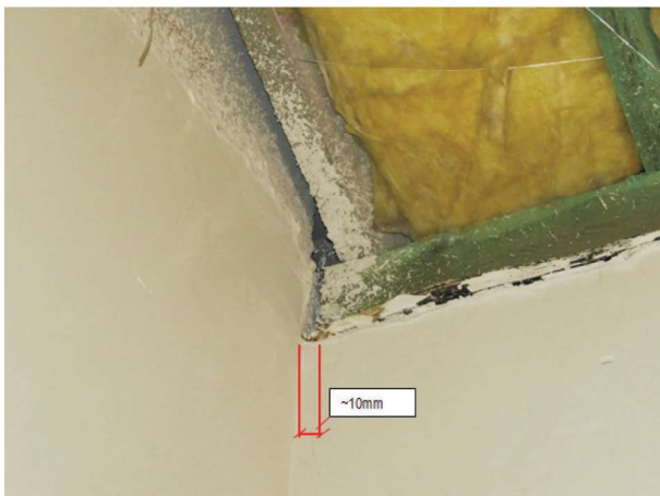
Rys. 13. Przesunięcie belek dachowych o ok. 1 cm od ściany w segmencie 2 (mieszkanie 3) (Praca ... 2016)
