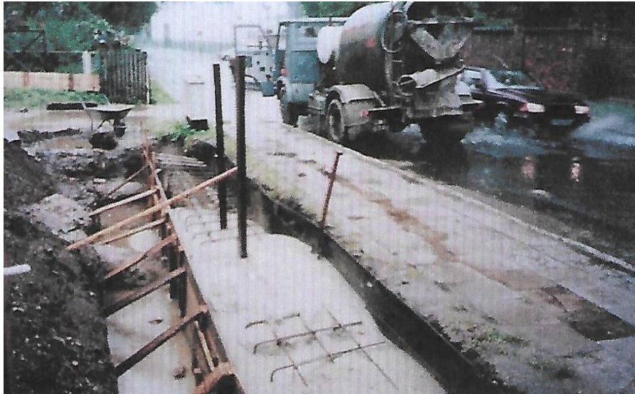
Fot. 1. Prace wzmacniające podłoże gruntowe – Świebodzin, dz. nr 166/5 (2002r.) Photo 1. Reinforcing works on ground structure – Świebodzin, land plot no. 166/5 (2002)
