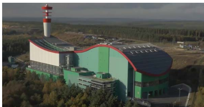
Fig. 1. Plant for energy recovery from municipal waste (ZEVO) in Chotíkov [photo ZEVO Chotíkov] Rys. 1. Spalarnia odpadów komunalnych (ZEVO) w miejscowości Chotíkov
