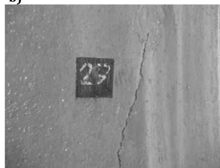
Rys. 8.4 Szczelina w obudowie betonowej szybu: a) szczelina pozioma, b) szczelina skośna
