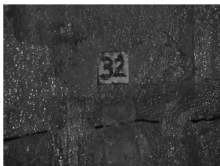
Rys. 8.4 Szczelina w obudowie betonowej szybu: a) szczelina pozioma, b) szczelina skośna
