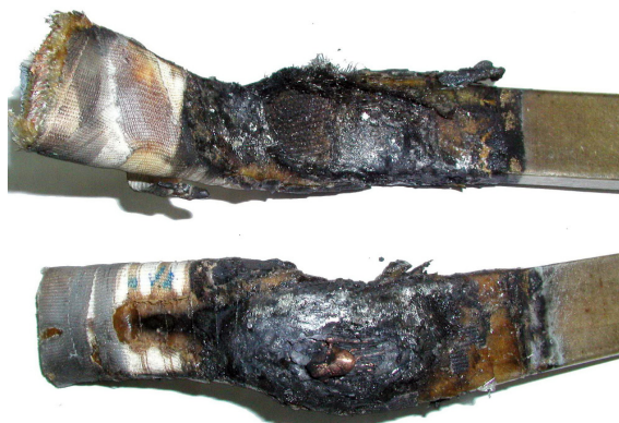
Rys. 15. Skutki wytarcia izolacji głównej
