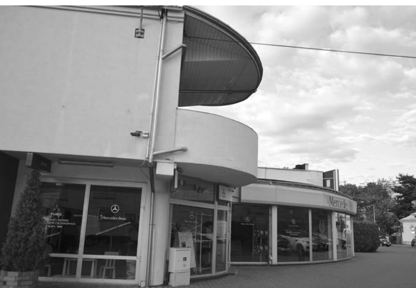
il. 4.4. „Salon Mercedesa” w Krakowie. Fot. W. Kosiński. W głębi – nowy, drugi etap inwestycji jest konsekwentnym rozwinięciem wcześniejszej kompozycji form obłych, przy czym funkcja ekspozycyjna uzasadnia znaczne przeszklenia elewacji / „The Mercedes Car Dealership” in Kraków. Phot. by W. Kosiński. In the background: the new, second stage of the project is a consequent development of the earlier composition of organically shaped forms, with the exposition justifying the large glazed area of the facade
