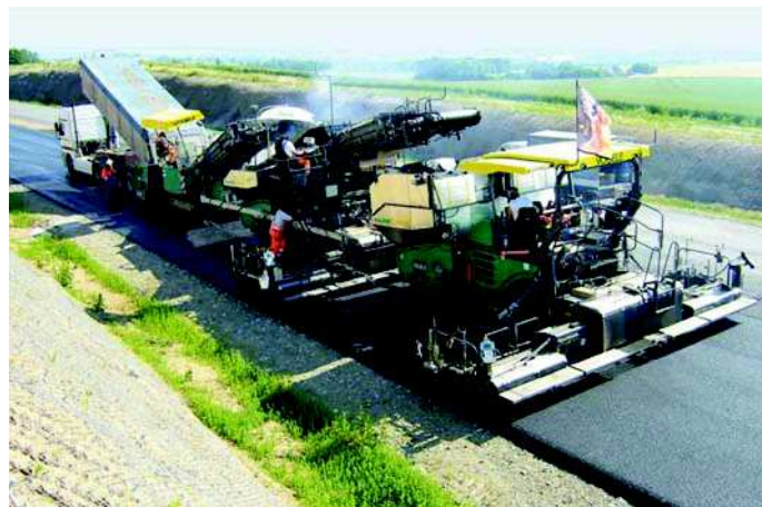
Fot. 2. Jednoczesne wykonywanie warstw wiążącej i ściernalnej w technologii InLine Pave [13]
