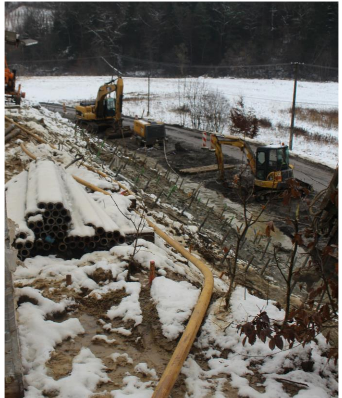
Rys. 2. Prace przy zabezpieczeniu skarpy (opr. własne, 2.12.2016r)
