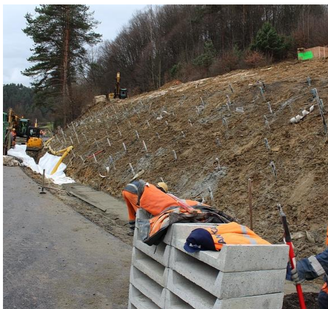
Rys. 4. Zabezpieczona skarpa drogowa [11]
