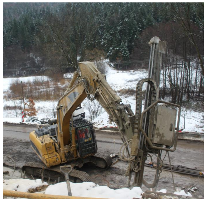
Rys. 3. Gwoździowanie skarpy (opr. własne, 2.12.2016r)
