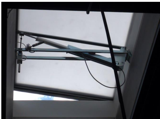
Rys. 2. Liniowy siłownik elektromechaniczny z przekładnią śrubową sterujący otwieraniem klapy oddymiającej na dachu budynku
