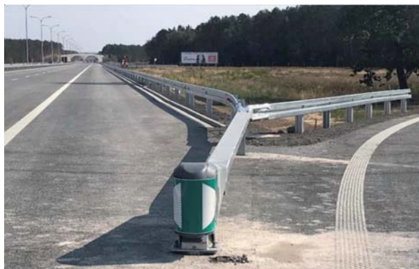
Fot. 5. Przykłady zastosowania urządzeń energochłonnych SE: a) charakterystyczna kieszeń, b) urządzenie energochłonne zainstalowane w skrajni drogi
