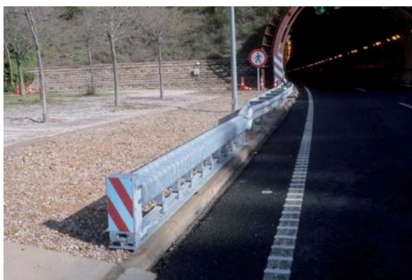
Fot. 3. Przykład urządzenia energochłonnego hybrydowego SMA T4 „The” End terminal: a) wjazd do tunelu, b) roboty drogowe tymczasowe
