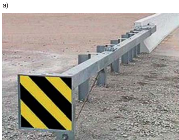
Fot. 2. Przykłady urządzeń energochłonnego hybrydowych: a) Box Beam Bursting Energy Absorbing Terminal – Single Side Crash Cushion, b) Hybrid Energy Absorbing Reusable Terminal
