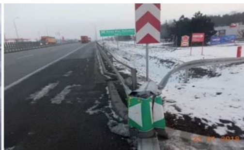
Fot. 4. Przykłady zastosowania urządzenia SE: a) jako terminala zderzeniowego na zakończeniu bariery rozdzielającej drogę zbiorczą od jezdni głównej, b) zakończenia bariery na zjeździe łącznicy z jezdni głównej
