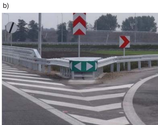
Fot. 1. Oslony energochłonne U-15: a) Poduszka zderzeniowa nienakierowująca ALPINA [3], b) Poduszka zderzeniowa typu Saferoad CrashGuard nakierowująca
