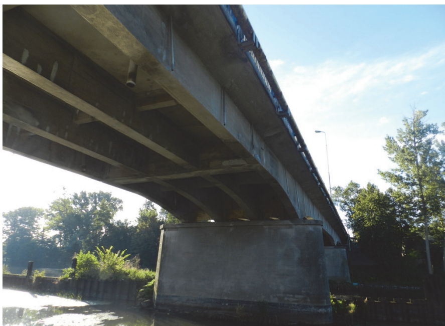
Rys. 6. Widok na przęsło od spodu – most przez Gwdę w Ujściu
