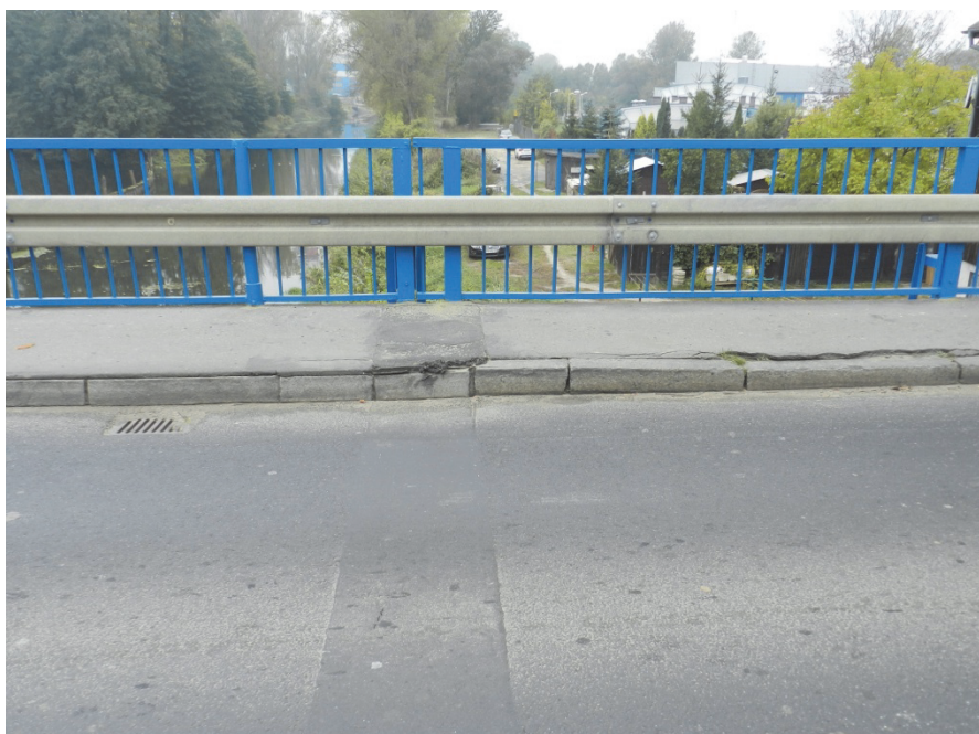
Rys. 15. Przekrycie dylatacyjne w miejscu przegubu
