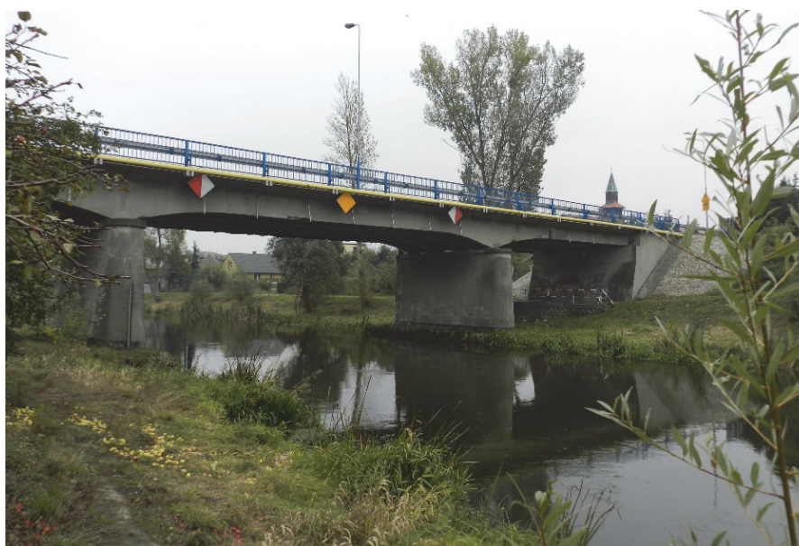
Rys. 3. Widok z boku na most przez Noteć w Ujściu
