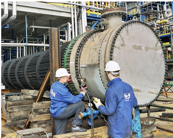
Rys. 3. Prace przy budowie Rafinerii Gdańskiej (10 tys. połączeń)
