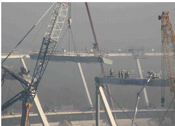
Rys. 4. Prace przy budowie Stadionu Śląskiego (8 tys. połączeń)
