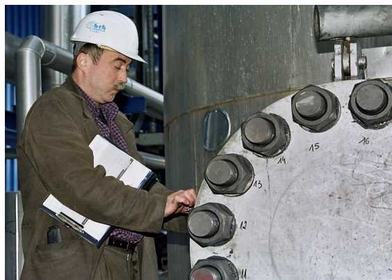
Rys. 1. Przykłady połączenia śrubowego
