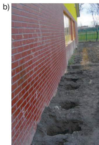
Rys. 5. Plan sytuacyjny z rozmieszczeniem otworów badawczych (a) i podbijanie fundamentów (b)
