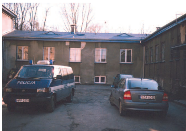
Rys. 4. Budynek w części przeznaczonej do nadbudowy
