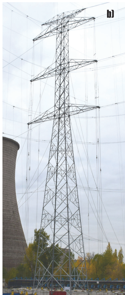
Rys. 1. Geometria badanego słupa EN422:BR:16 P (H=58,495 m): a) schemat, b) widok
