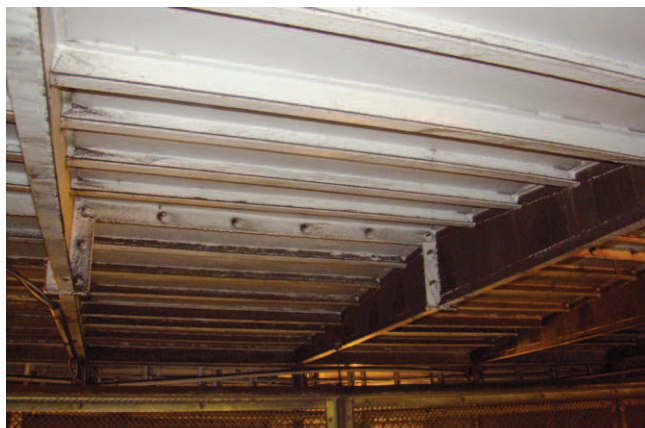
Rys. 4. Widok od wewnątrz na dach galerii transportowej
