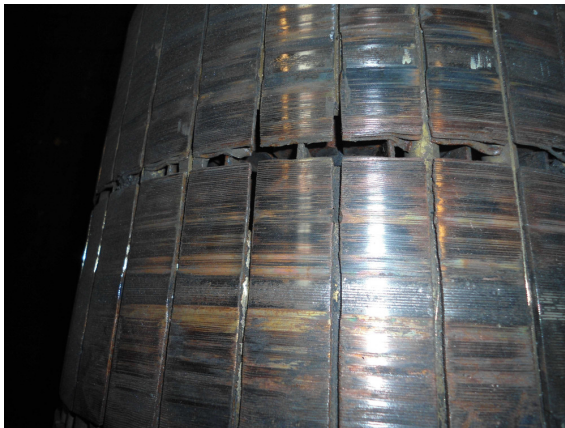
Rys. 6. Widok miejsca uszkodzenia prętów klatki wirnika badanego silnika
