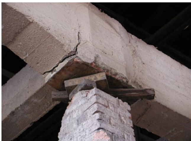
Rys. 14. Przykład oparcia rusztu żelbetowego
