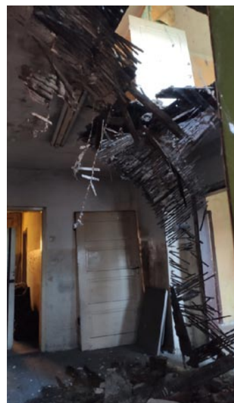
Rys. 6. Fragment zniszczonego stropu
