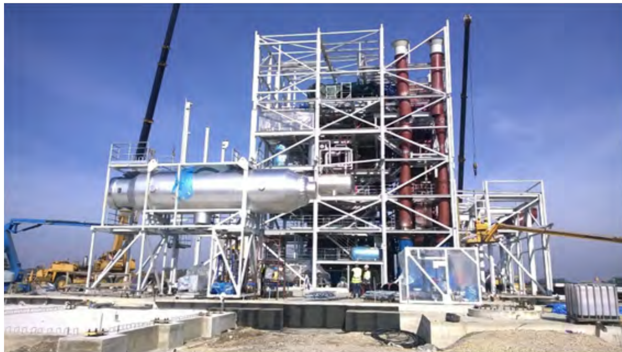
Gotowe moduły ułatwiają szybką instalację. Podnoszenie modułu skraplacza elektrociepłowni BioPower
