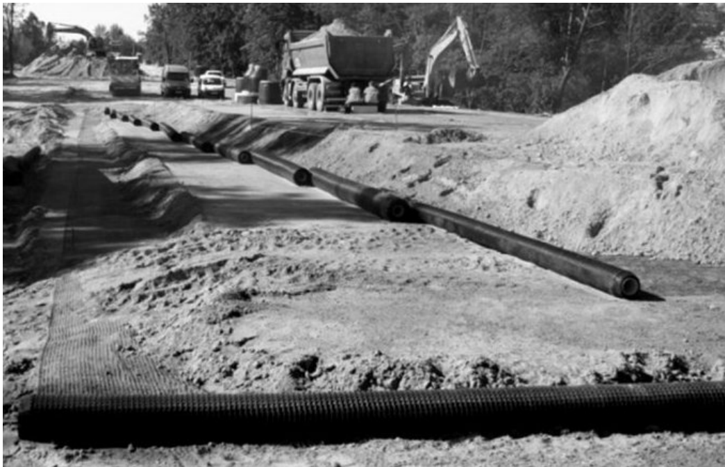
Rys. 1. Widok badanych warstw nasypu korpusu drogowego
