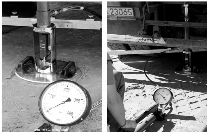
Rys. 5. Badania modułów odkształcenia podłoża płytą VSS
