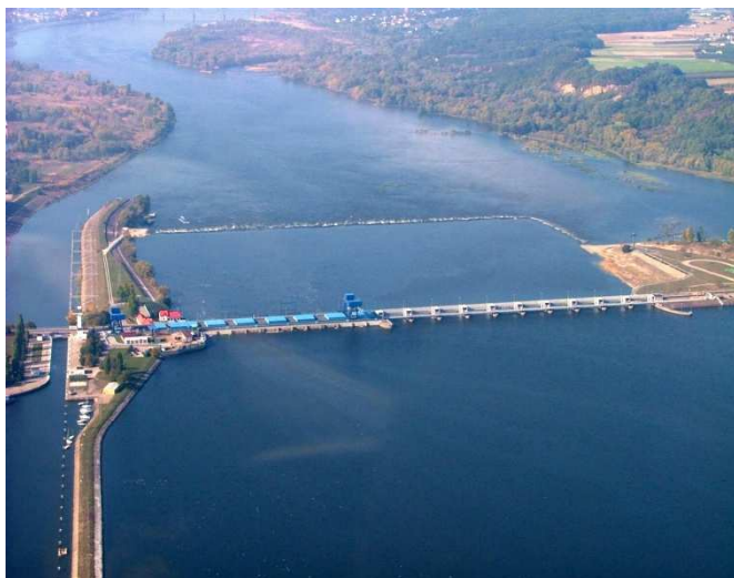
Rys. 3. Stopień Włocławek – widok od wody górnej [19]
