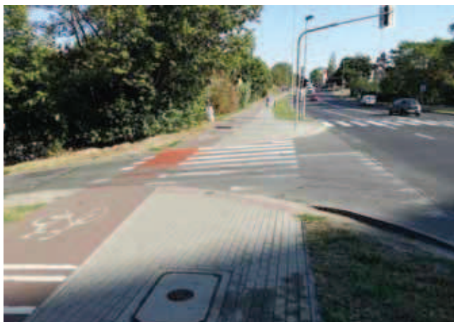
Rys. 2. Niebezpieczne z powodu braku widoczności, skrzyżowanie ulicy „pod górę” ze ścieżką rowerową z pierwszeństwem przejazdu
