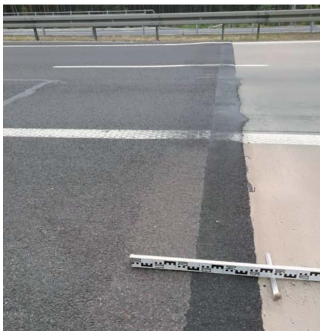
Fot. 1 i Fot. 2. Uszkodzenie i deformacje na styku różnych rodzajów nawierzchni. Autostrada A4 [9]
