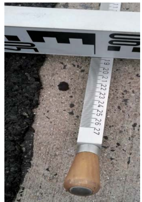
Fot. 1 i Fot. 2. Uszkodzenie i deformacje na styku różnych rodzajów nawierzchni. Autostrada A4 [9]
