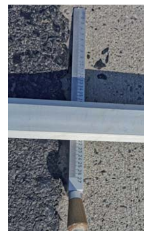
Fot. 5 i Fot. 6. Uszkodzenie nawierzchni asfaltowej – wyruszenia i pełzanie nawierzchni na styku z nawierzchnią betonową. Autostrada A4 [15]
