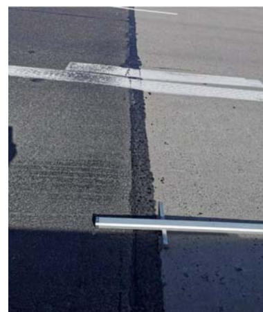
Fot. 5 i Fot. 6. Uszkodzenie nawierzchni asfaltowej – wyruszenia i pełzanie nawierzchni na styku z nawierzchnią betonową. Autostrada A4 [15]
