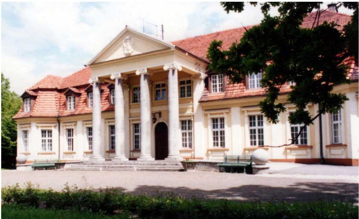
Ryc. 1. Pałac w Bieganowie, elewacja frontowa, 1978. Źródło: zbiory prywatne prof. Z.J. Białkiewicza Fig. 1. Palace in Bieganowo, front elevation, 1978. Source: private archive of Z.J. Białkiewicz
