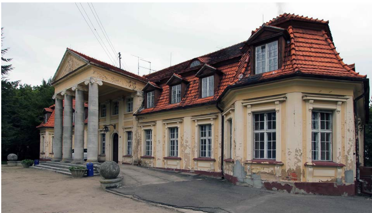
Ryc. 20. Pałac w Bieganowie, elewacja frontowa, zawilgocone ściany, odpadający tynk, stan obecny. Źródło: zbiory prywatne J.J. Białkiewicz
