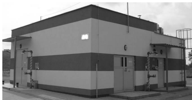
Rys. 4. Budynek magazynowy hydrazyny w 31 Bazie Lotnictwa Taktycznego w Krzesinach [25]
