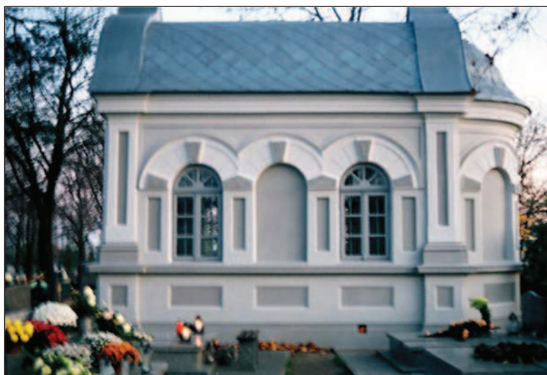
Fot. 2. Cmentarz wojskowy na Osiedlu Majków – miejsce pochówku mjr Stefana Waltera w kaplicy grobowej
