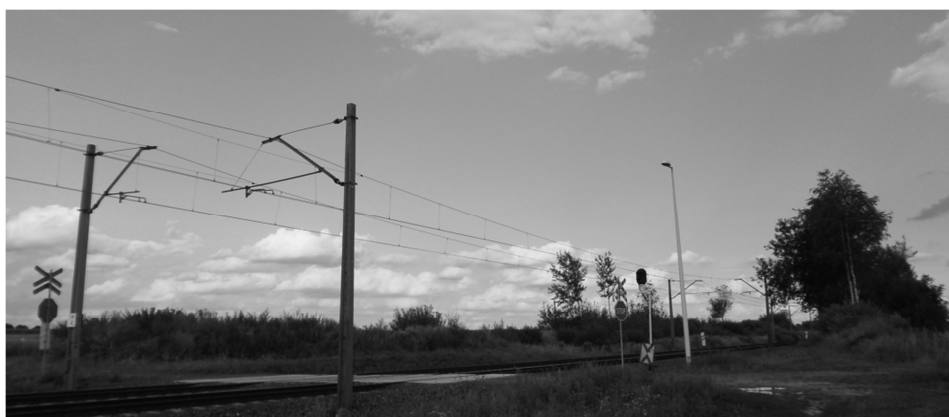
Rys. 5. Przejazd kolejowo-drogowy kategorii D (fotografia własna)
