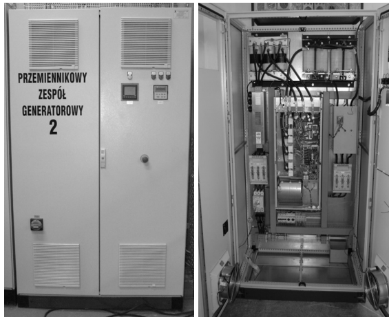
Rys. 8. Widok przekształtnika energoelektronicznego o mocy 90 kW
