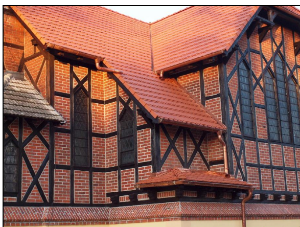
Fot. 7. Kościół pw. Chrystusa Króla w Postolinie, fragment elewacji południowej.
