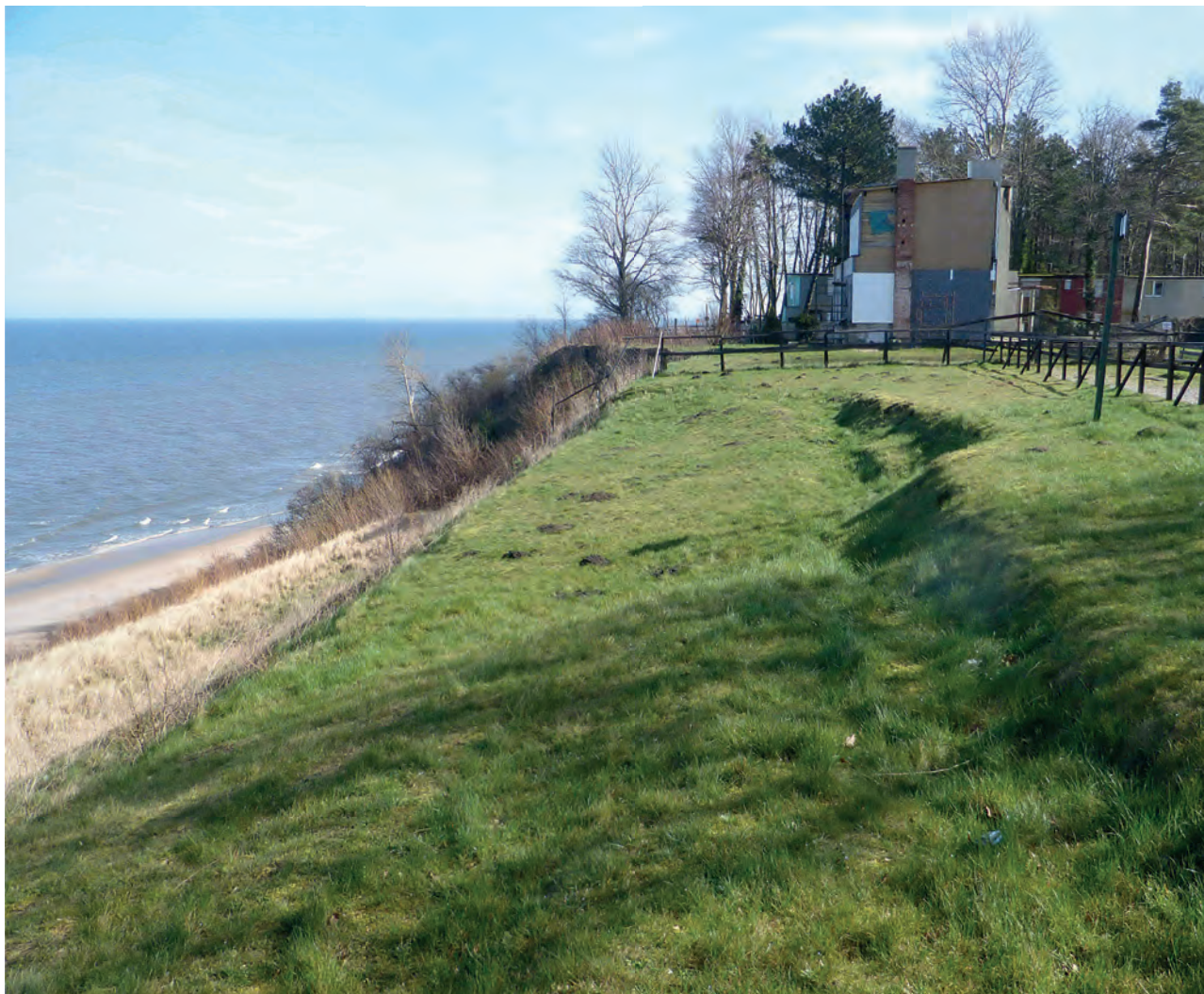
Ryc. 2. Skarpa główna osuwiska na koronie klifu (km 133,6–133,7). Fot. L. Zabuski
