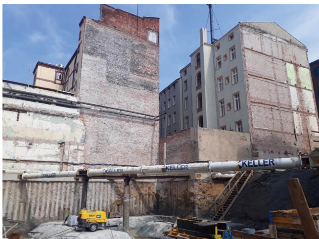
Rys. 9. Palisada zabezpieczająca sąsiednią zabudowę
