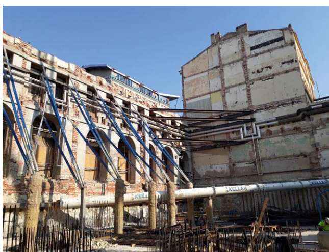
Rys. 10. Zabezpieczenie ściany elewacyjnej
