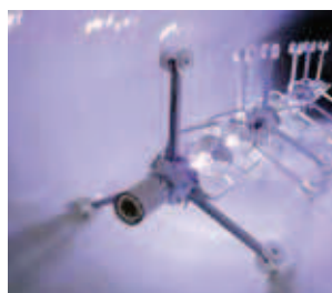
Rys. 12. Utwardzanie rękawa za pomocą lamp UV [20]
