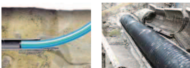
Rys. 19. Instalacja nowego rurociągu z PE poprzez wciągnięcie do rurociągu poddawane renowacji [20]
