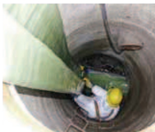
Rys. 8. Wprowadzenie rękawa do kanału poprzez studzienkę kanalizacyjną [10]
