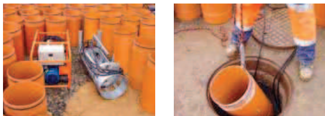
Rys. 23. Po lewej: moduły rurowe wraz z zestawem montażowym; po prawej: montaż modułu poprzez właz kanalizacyjny [17]
