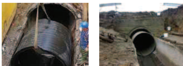
Rys. 21. Montaż poszczególnych modułów w komorze roboczej [16]
