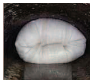
Rys. 13. Inwersyjny montaż rękawa w rurociągu [20]
