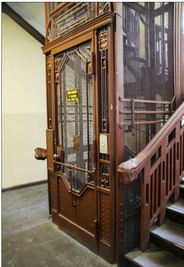
Ryc. 1. Poznań, kamienica mieszkalna, pl. Wolności 14, szyb dźwigowy, widoczne oryginalne drzwi szybowe, stan na rok 2016; fot. K. Pietrzak.
