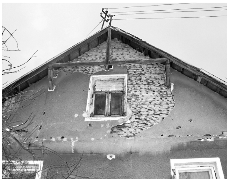
Ryc. 3. Drugi budynek mieszkalny z polan opałowych we wsi Białe-Szczepanowice; fot. A. Sołowińska, 2014 Fig. 3. A second cordwood house in Białe-Szczepanowice; photo by A. Sołowińska, 2014
