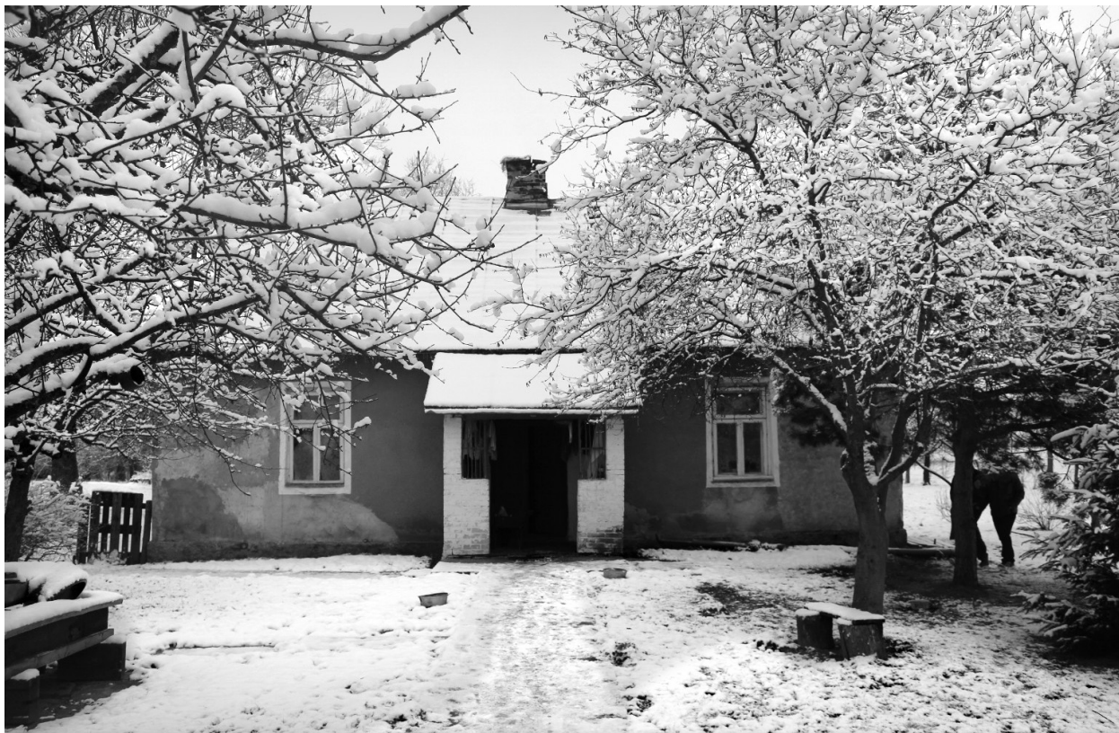
Ryc. 4. Drugi budynek mieszkalny z polan opałowych we wsi Białe-Szczepanowice; fot. A. Sołowińska, 2014
