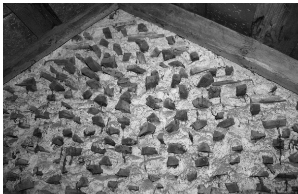
Ryc. 6. Budynek mieszkalny z polan opałowych we wsi Szpice-Chojnowo; fot. A. Solowińska, 2014
