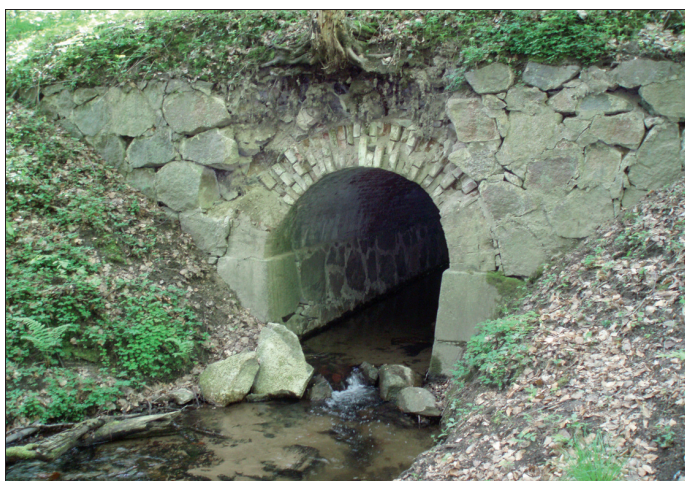
Fot. 3. Przepust kamienny, droga Koszalin – Sianów zbudowana w 1833 roku
