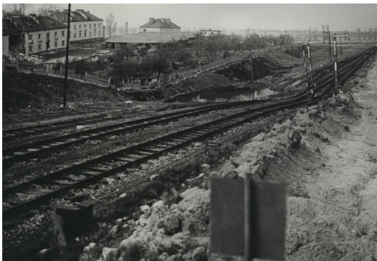
Ryc. 3a. Szkody górnicze w Wapnie spowodowane wdarciem wód w okresie 1977-1978 r. (Fotogrametryczny pomiar..., 1978)
