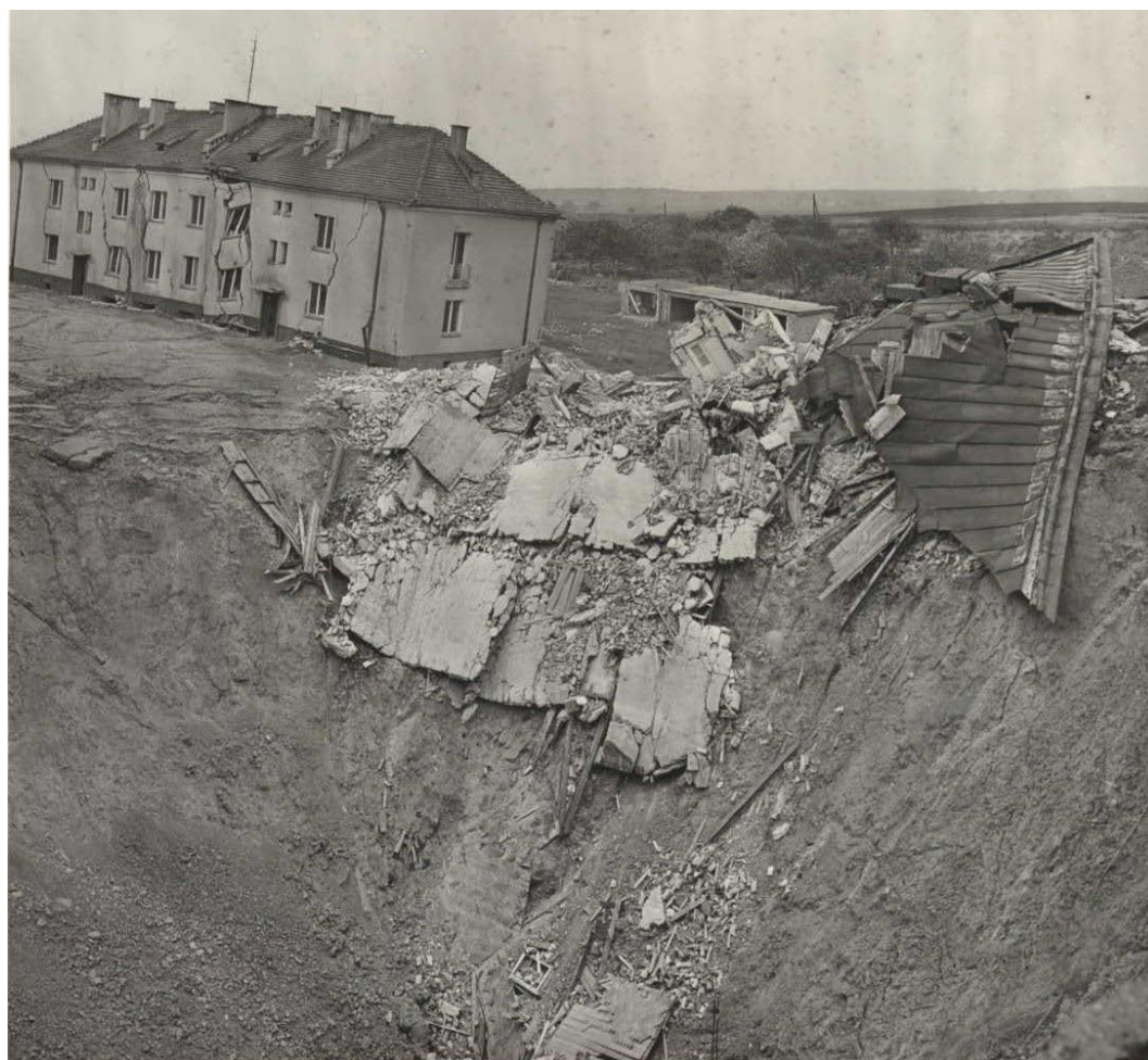
Ryc. 3b. Szkody górnicze w Wapnie spowodowane wdarciami wód w okresie 1977-1978 r. (Fotogrametryczny pomiar..., 1978)
