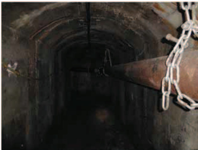
Rys. 2. Wyrobisko w obudowie betonowej w bezpośrednim sąsiedztwie georeaktora wraz z instalacją odprowadzającą gaz procesowy
