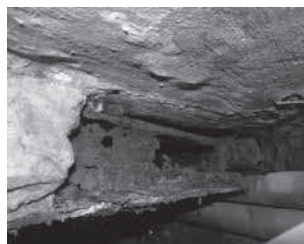
Rys. 4. Zdegradowana struktura belek stalowych w efekcie procesów korozyjnych [8]
