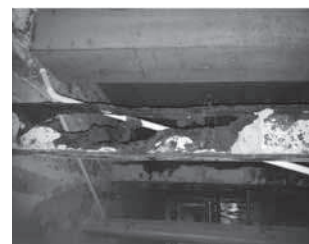
Rys. 4. Zdegradowana struktura belek stalowych w efekcie procesów korozyjnych [8]
