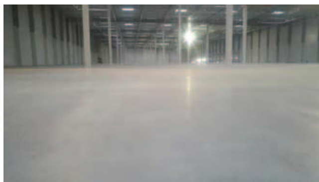
Rys. 2. Posadzka bezspoinowa utwardzona powierzchniowo [5] (archiwum autorów)
