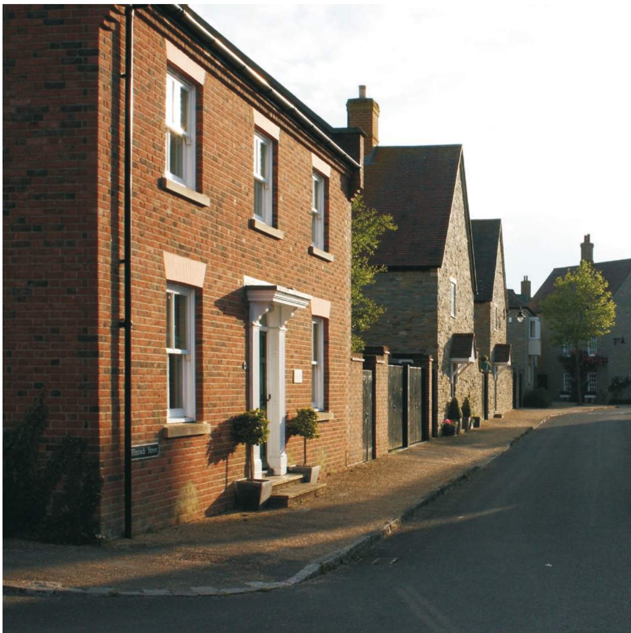
Ryc. 8. Poundbury, dzielnica Middle Farm. Hintock Street, widok w kierunku zachodnim. Zwracają uwagę nadproża ceglane wg wzorca z ryc. 6a) oraz sposób wykonania zadaszeń nad wejściami; źródło: A. Zaguła 2014
