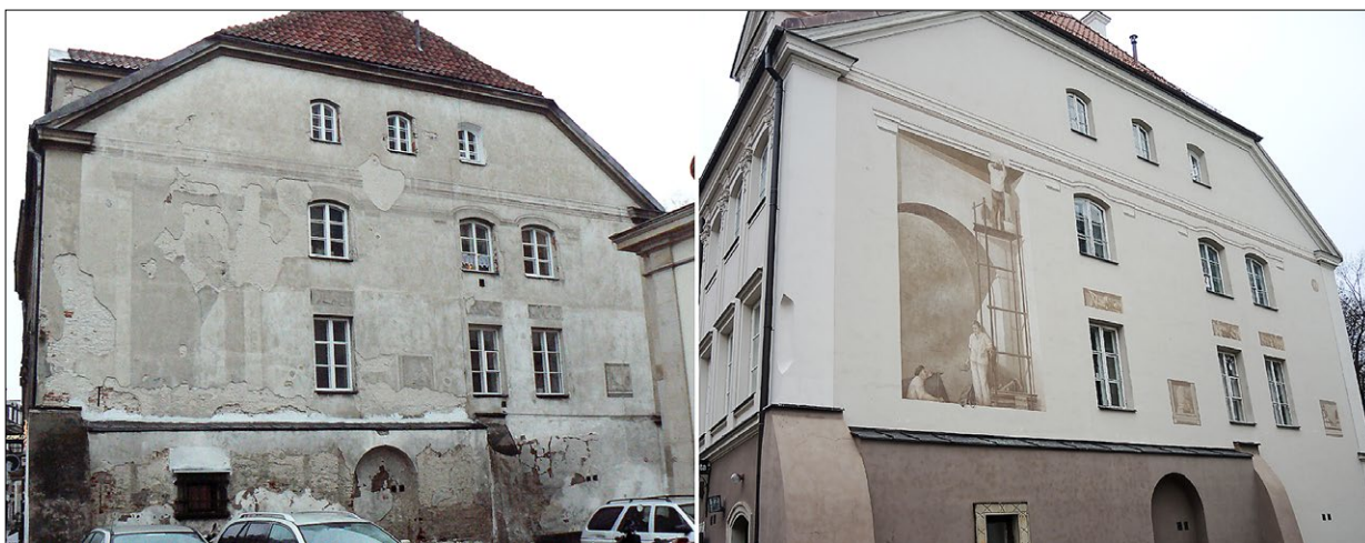
Ryc. 7. Kamienica przy ul. Freta 12, ściana szczytowa przed skuciem tynków oraz po narzuceniu nowych tynków i rekonstrukcji malowidła B.T. Urbanowicza; fot. T. Sawicki. Fig. 7. The tenement house at 12 Freta Street, the gable wall before plastering and after applying new plasters and reconstruction of the painting by B.T. Urbanowicz; photo by T. Sawicki.
