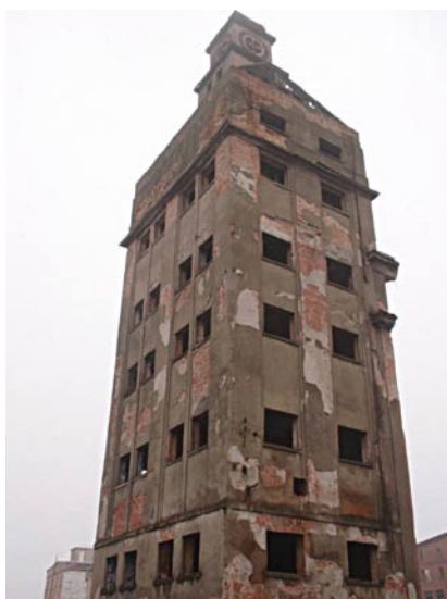
Rys. 2. Widok wieży – stan w roku 2018
