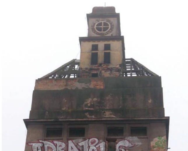
Rys. 7. Górna część wieży – stan w roku 2018
