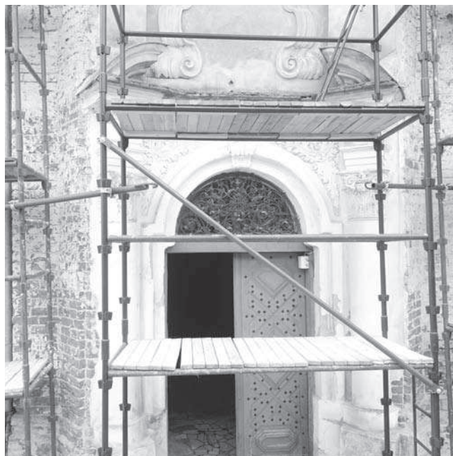
Rys. 2. Dobrze zachowany portal na tle ściany wschodniej z usuniętym tynkiem
